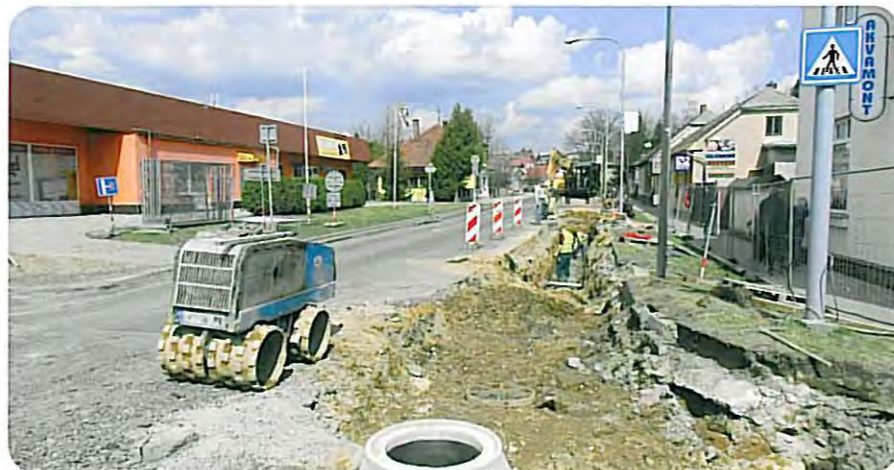
Stavba kanalizace v ulici Jungmannova
