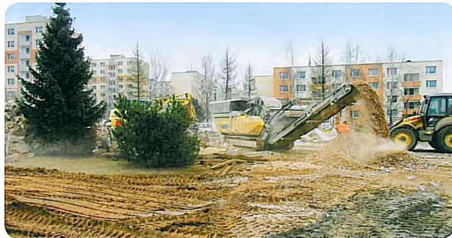
Demolice budovy dopravního hřiště
