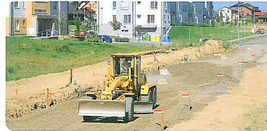
Výstavba vozovkových vrstev ze štěrku
