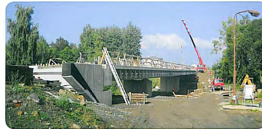
Výstavba mostu přes Sázavu
