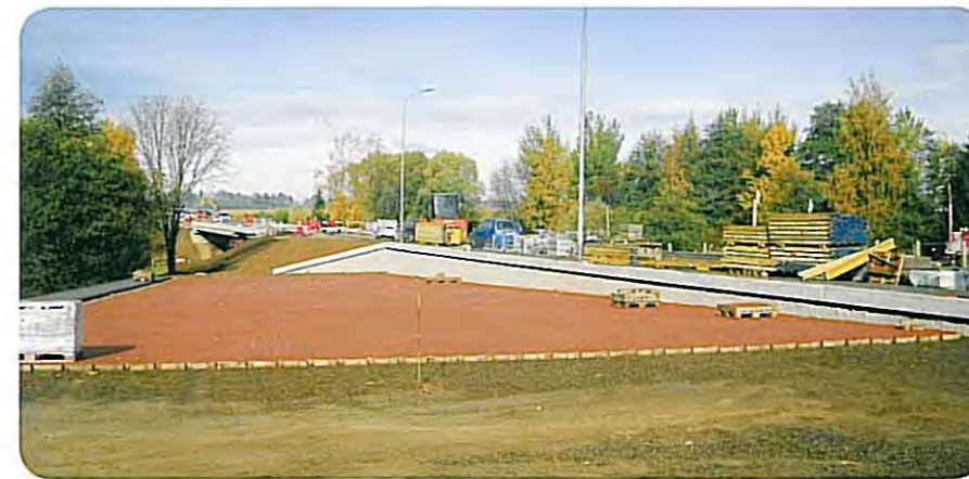
SO 202: opěrná zeď v km 0,263 - 0,333
