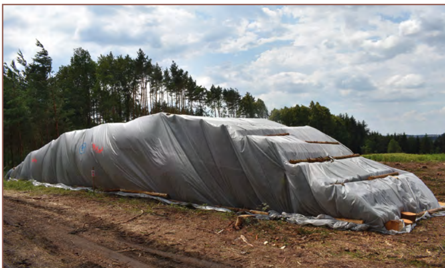
Obr. 23: Skládka asanovaná technologií MERCATA
