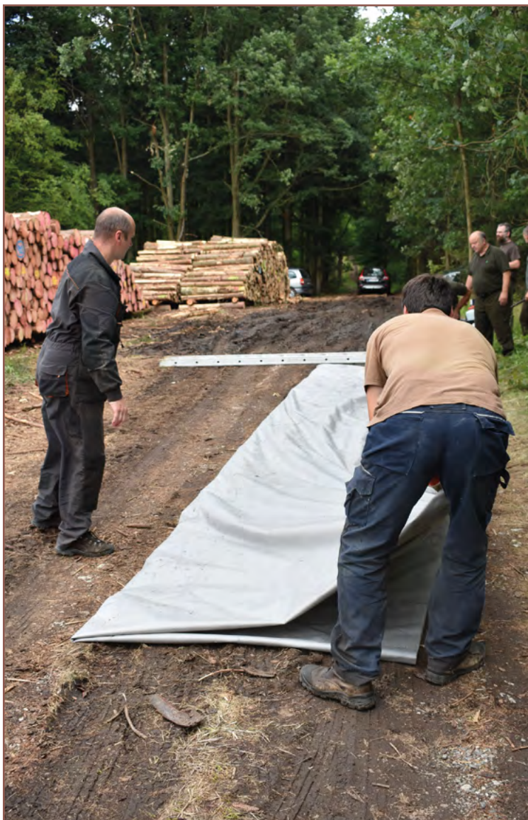
Obr. 19: Příprava textilie
