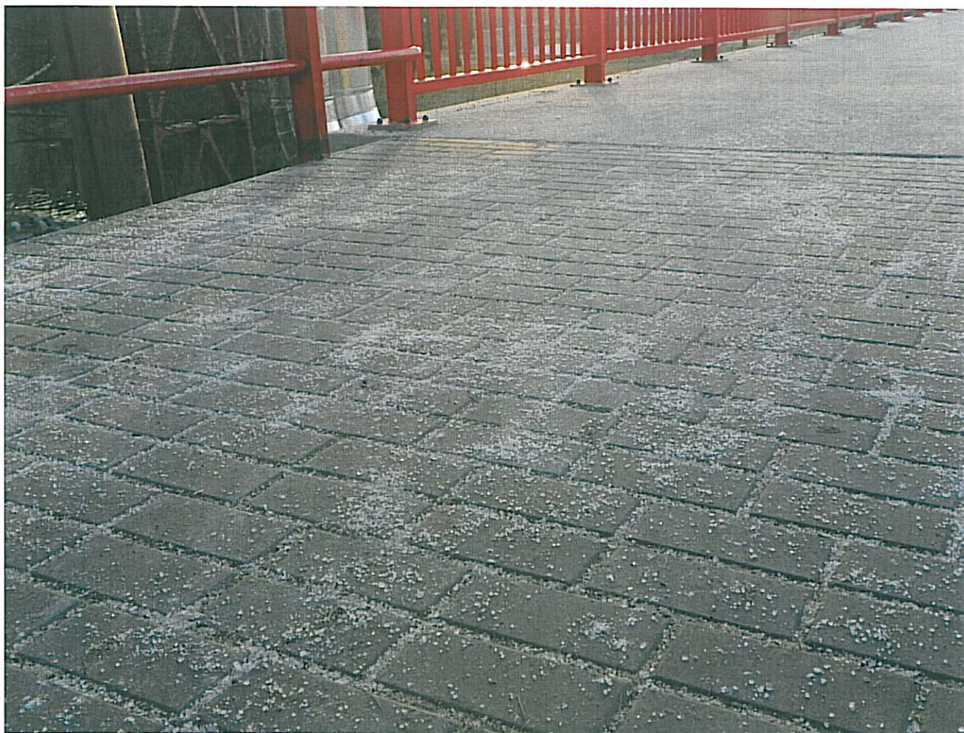
nově zrekonstruovaný most u jezu na Sázavě 22.3.2011 večer, po třech dnech
