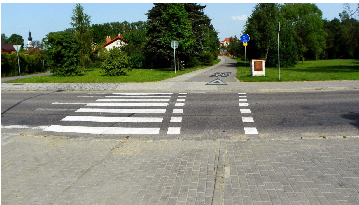
příklad správného řešení přejezdu přes Strojírenskou ul.
