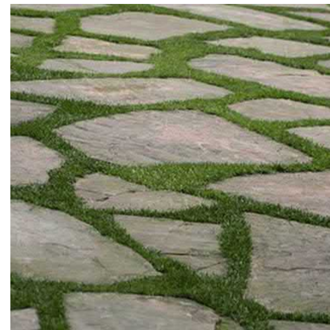
Nepravidelná kamenná dlažba s travnatou spárou - nábreží
