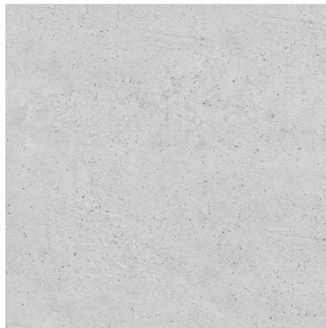
Betonový povrch - terasa Domu kultury
