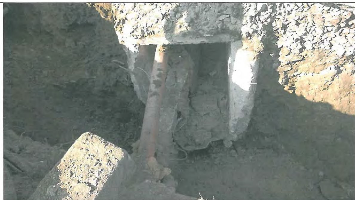
vybourání horkovodního kolektoru
