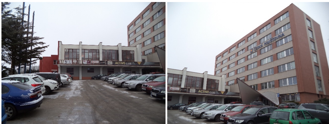
Obrázek 1 Pohledy na objekt
