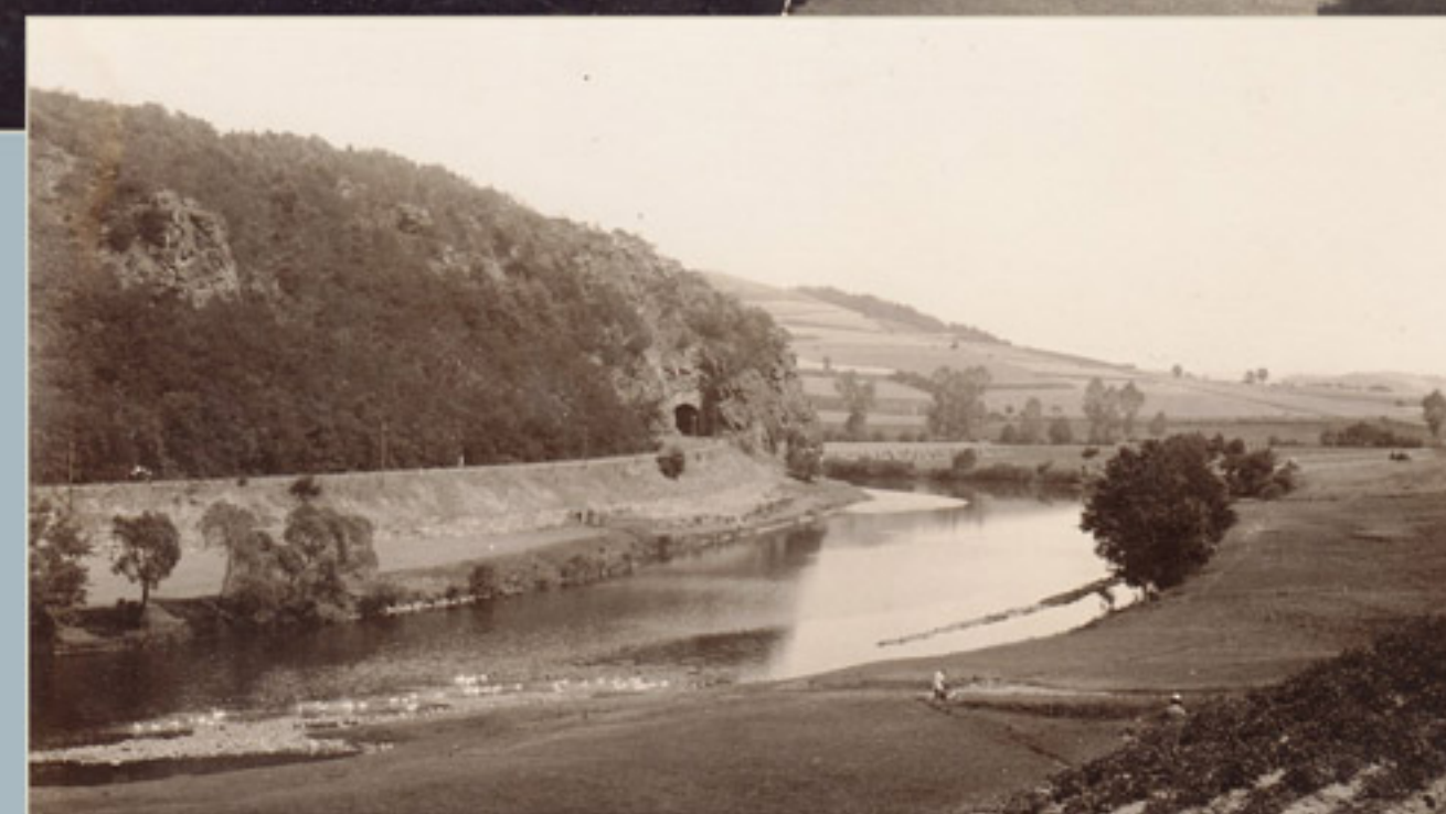
▲◀ Kácovský tunel, dlouhý 93 metrů, leží mezi kilometry 4,148–4,241 (sbírka J. Džurný). Vlevo portál Kácovského tunelu s inspektorskou drezínou krátce po dokončení drá- hy (sbírka F. Pleva)
