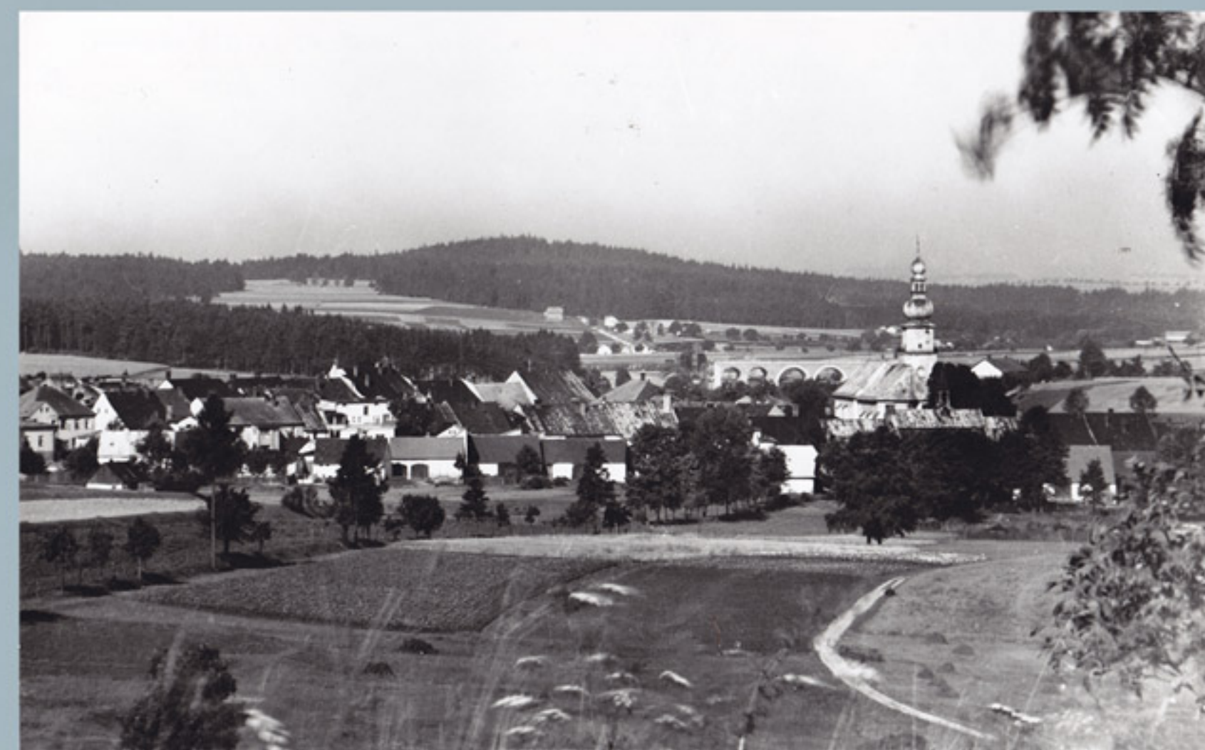
▲◀ Pohled na Město Žďár s rozestavěným viaduktem nového železničního spojení mezi Brnem a Německým (později Havlíčkovým) Brodem. O stavbě dráhy rozhodla vláda v listopadu 1938, zprovozněna ale byla až po patnácti letech. Vlevo záběr na odstraňování bednění z jednoho z železobetonových oblouků žďárského viaduktu (RM Žďár nad Sázavou)
