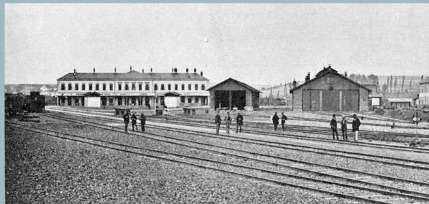
▲ Německobrodské nádraží s výtopy za nimiž stála točna. Napravo od výpravní budovy odjížděly vlaky do Pardubic a Žďáru. Na vedlejší straně stojí na havlíčkobrodské staré točně lokomotiva řady 475.179 ČSD Šlechtična (foto M. Šustr)
