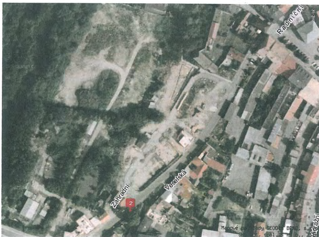
Obrázek č. 1: Stav lokality před výstavbou
