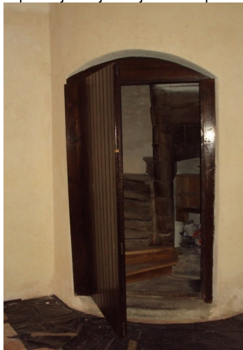
kaple Nejsvětější Trojice – vstup na kůr
