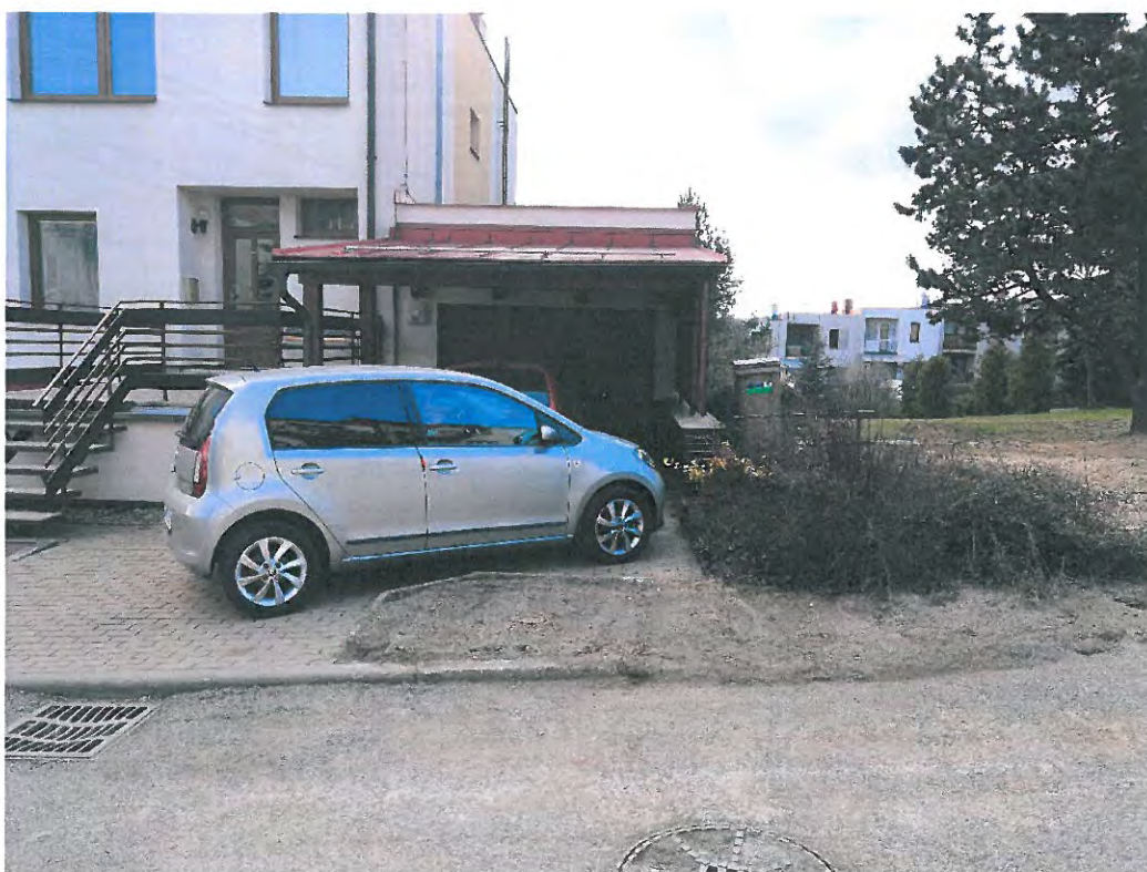
Stav po odstranění pojistkového pilíře
