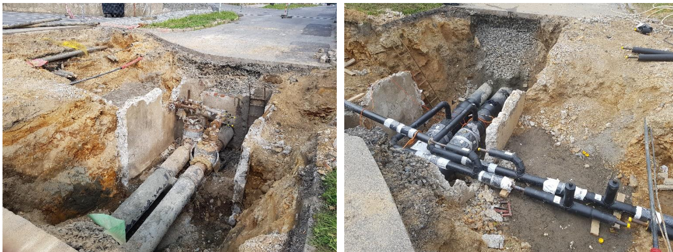
Obr. 1 Havárie šachty M47 (ul. Husova, Žďár nad Sázavou) před (vlevo) a po (vpravo) rekonstrukci
