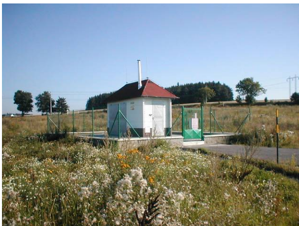
Regulační stanice plynu, prům. zóna Jamská
