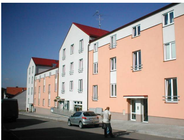
Bytový dům, ul. Veselská - 20 b.j.
