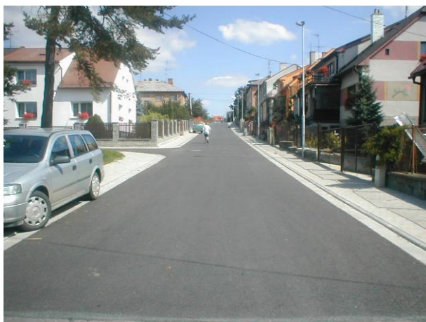
Rekonstrukce komunikací Vysočany
