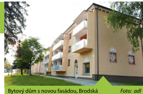
Bytový dům s novou fasádou, Brodská
