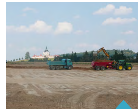
V polovině srpna 2016 byla zahájena výstavba technické infrastruktury Hrnčířské ulice, kterou provádí na základě výběrového řízení 1. žďárská plynárenská a vodařská a.s. Praha. Termín ukončení stavby je červen 2017 a její náklady činí 20 milionů korun bez DPH. Foto: adl
