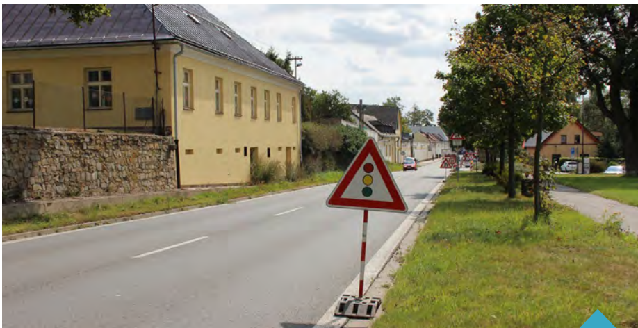
Omezení v ulici Santiniho. Kritériem výběrového řízení byla i doba realizace stavby.
