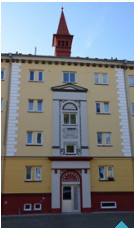
Rekonstrukce domu na ul. Brodská
