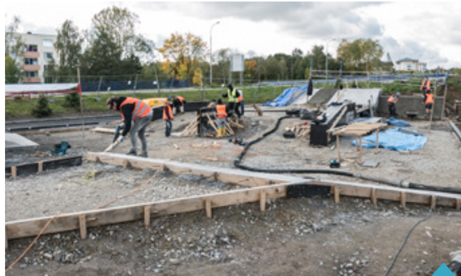
Výstavba nového skateparku
