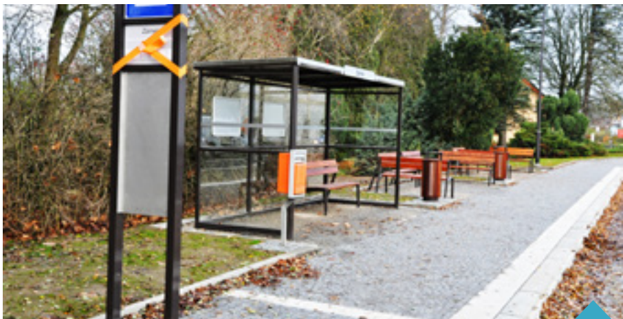
Zvýšení bezpečnosti dopravy na ulici Santiniho
