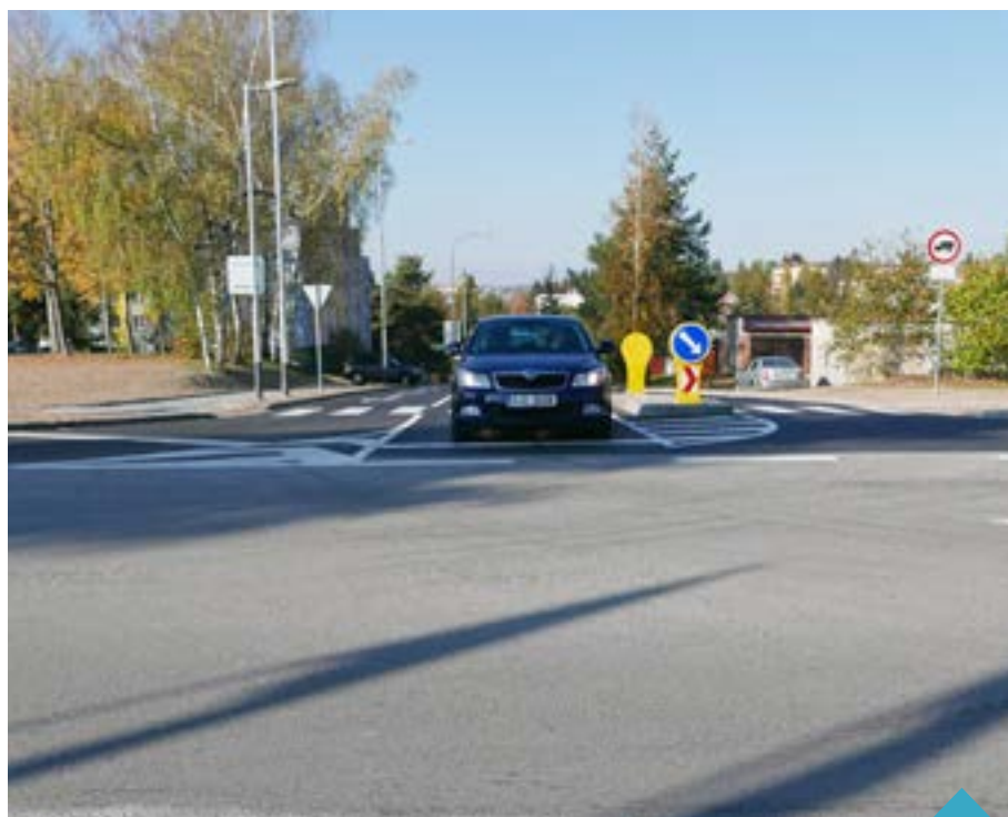
Nově opravená komunikace, která vede z centra města
