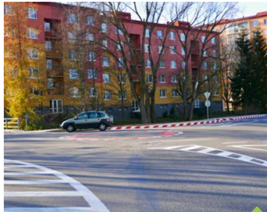
Nově upravená křižovatka slouží ve zkušebním provozu
