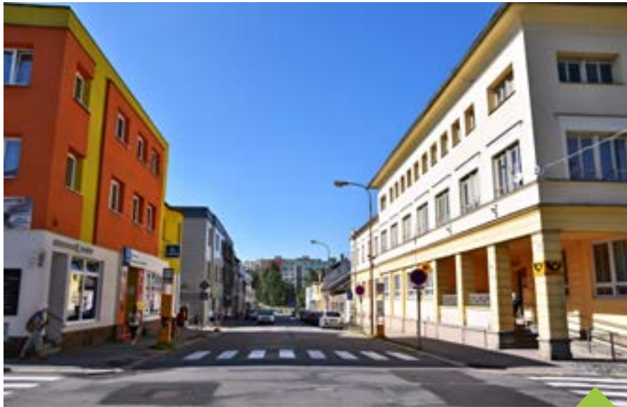
Nádražní ulice se po dlouhé době dočká zásadní rekonstrukce
