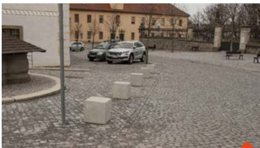
Příklad pohledové betonové kostky z Litomyšle
