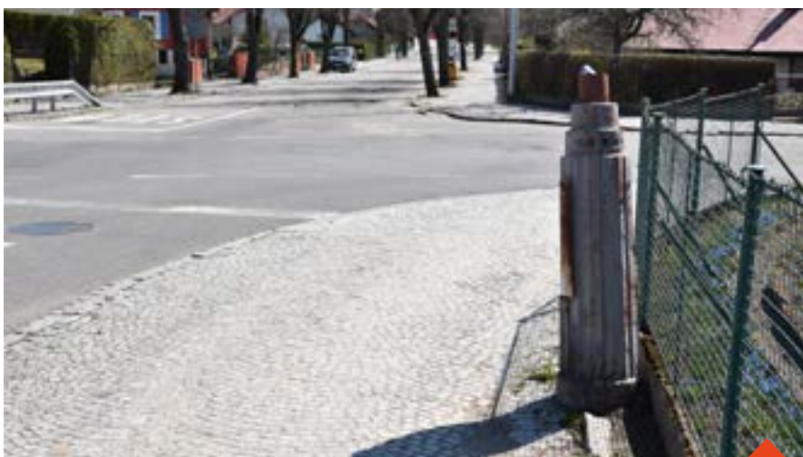
Zbytek sloupu pouličního osvětlení na Revoluční ulici
