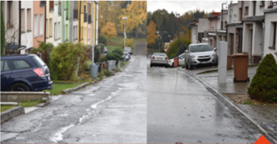
Vlevo neopravená spodní část a vpravo opravená vrchní část Makovského ulice
