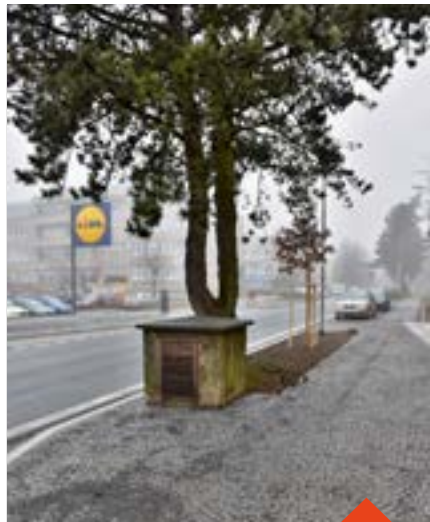
Větrací šachta průmyslové školy Foto: Matěj Papáček
