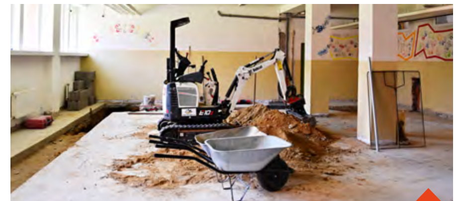
Stavební práce v šatnách 3. ZŠ
