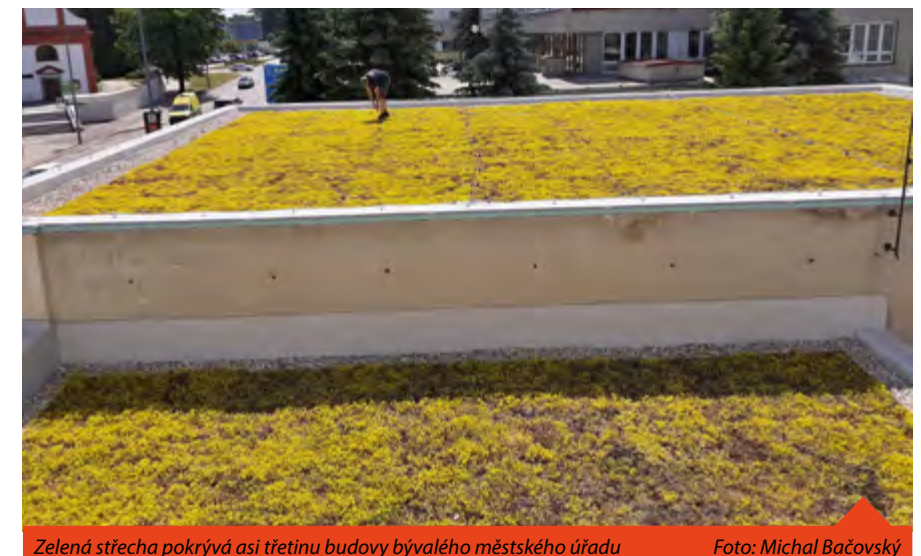
Zelená střecha pokrývá asi třetinu budovy bývalého městského úřadu
