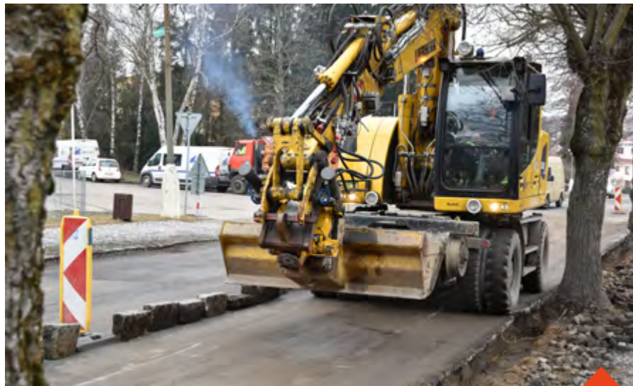
Oprava Strojírenské ulice
