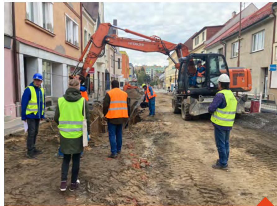
Oprava Nádražní ulice na podzim 2021
