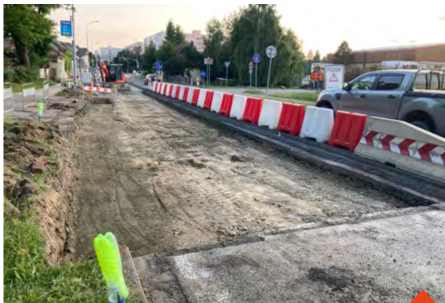
Oprava Jungmannovy ulice
