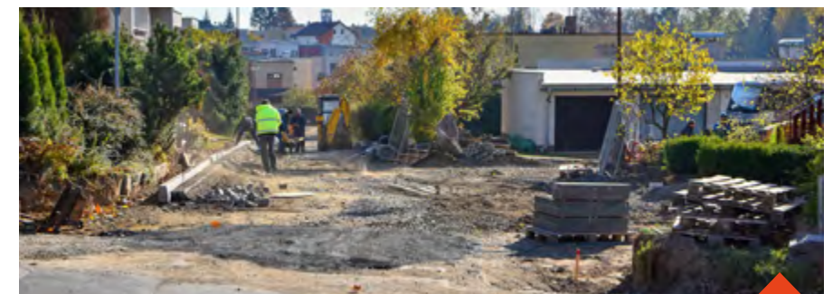
Rekonstrukce Vodojemu v roce 2021
