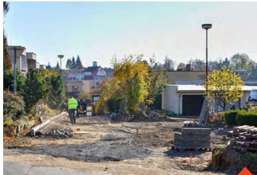
Práce na Vodojemu začaly 15. března a skončí v říjnu
