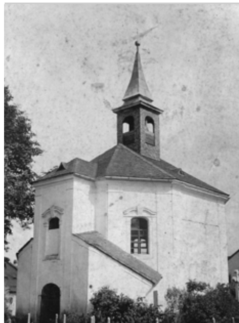
Kaple sv. Barbory ve Žďáře před pokrytím střechy plechem Foto: archiv RM
