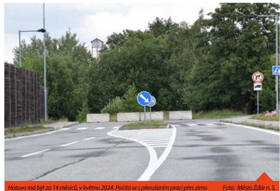
Hotovo má být za 14 měsíců, v květnu 2024. Počítá se s přerušením prací přes zimu
