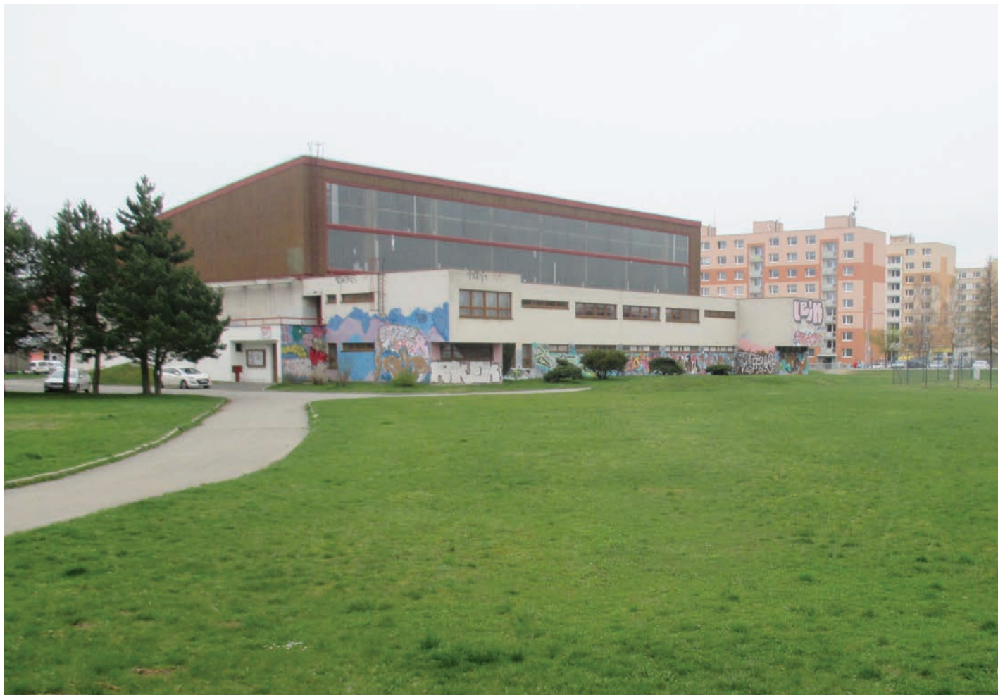
Pohled na sportovní halu od severovýchodu
