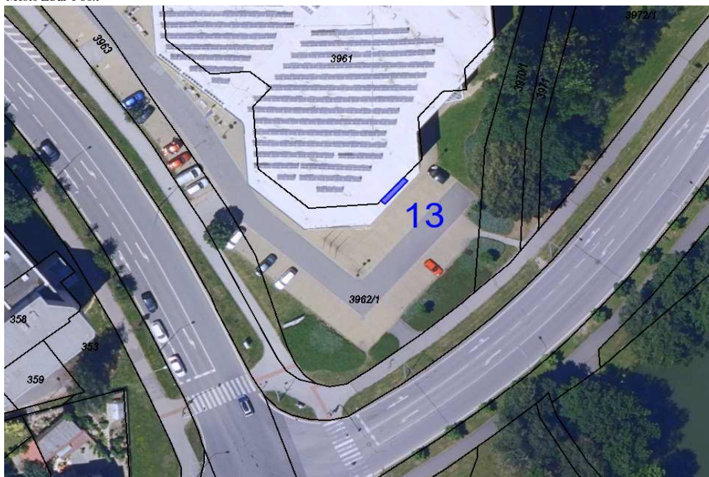
13 - ul. Horní k.ú. - u obvodové zdi obchodního centra Město Žďár I box
